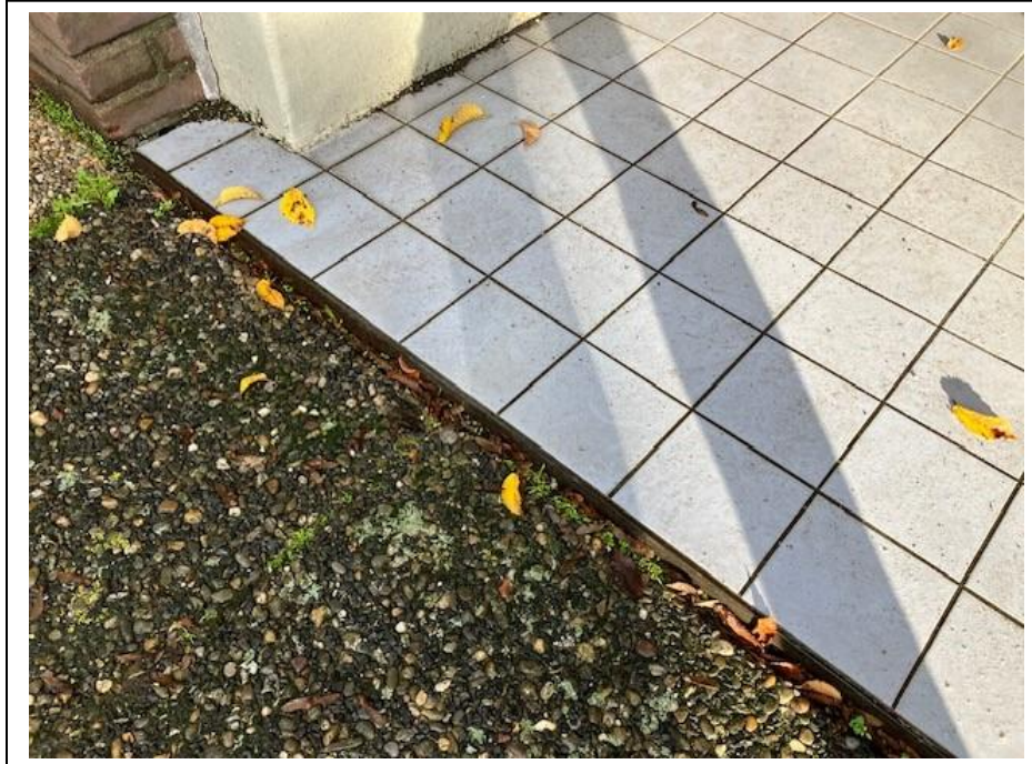
9. Aansluiting met stalen profiel ter plaatse van entree woning.
