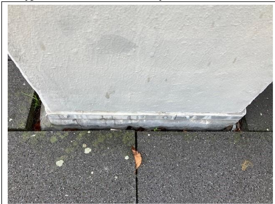
18. Opgaand werk onder lood en knelstrip.
