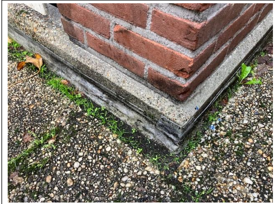
17. Conservering van lood over lood en opstand aangebracht.
